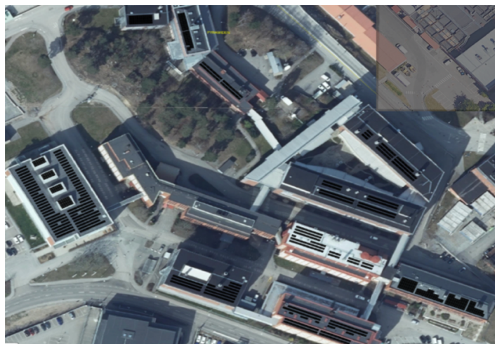
Figur 3: Flygfoto över upphandlade solpaneler för Pyramiden 19 [88]. Bild används med tillåtelse.
